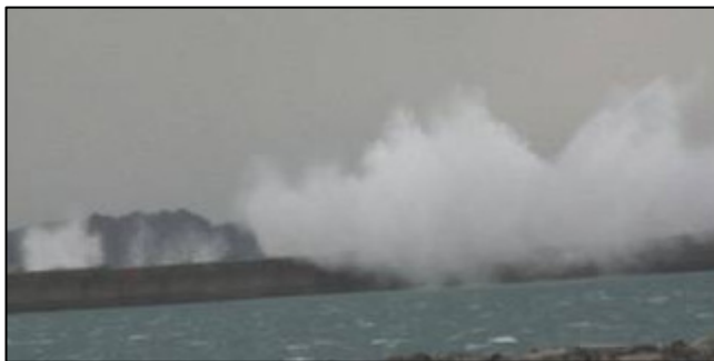
図-1 暴浪時の海岸構造物での打上げの様子
