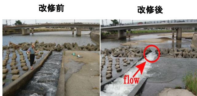
図 2 1-新道堰の魚道改修前後の様子
