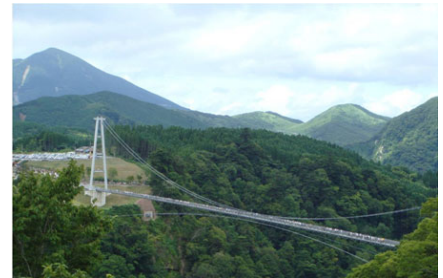
写真-1 九重夢大吊橋
