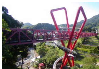
図 4 : 中尾城公園歩道橋
