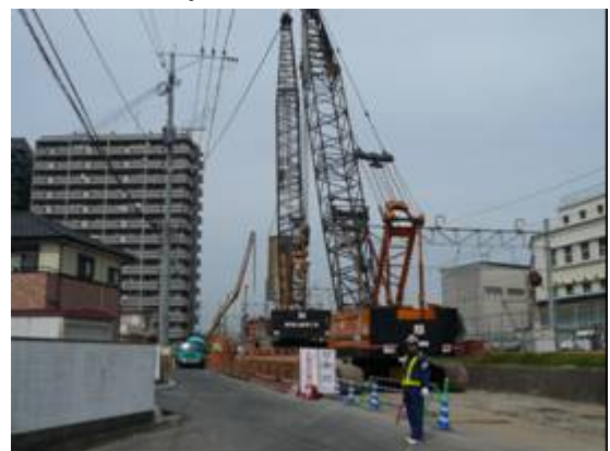
写真-2 場所打ち杭 ( \phi = 2.5\text{m} ) 施工状況
