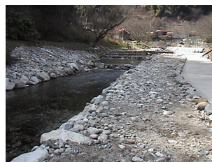
写真3 G地点改修直後
