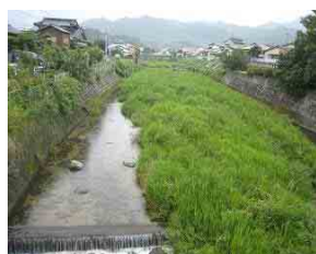
写真1 F地点改修前
