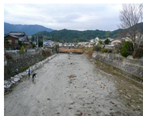
写真2 F地点改修後
