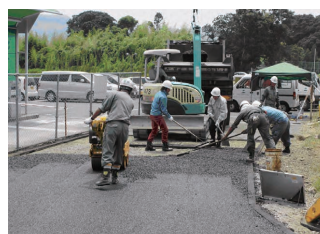
写真 - 3 施工風景
