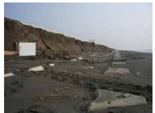
写真-2 養浜盛土の浜崖とアカウミガメの上陸跡（南工区）
