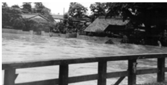
写真-4 昭和 38 年樋井川水害
