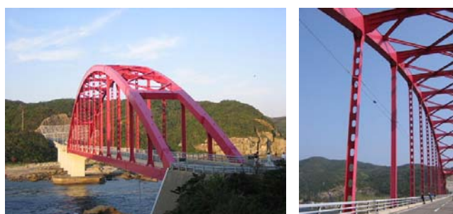
図-2 頭が島大橋
