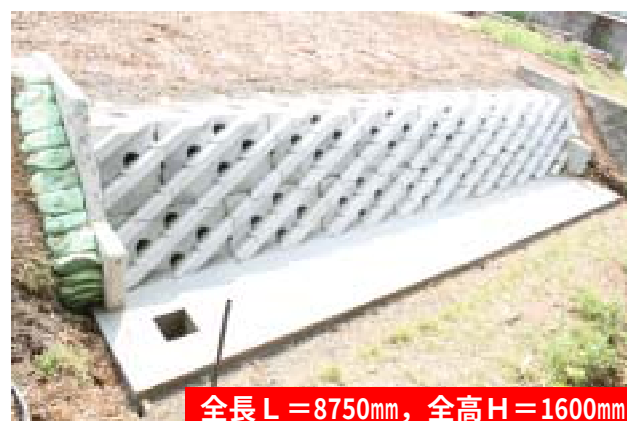
写真1 生物用通路付人工斜面の外観
