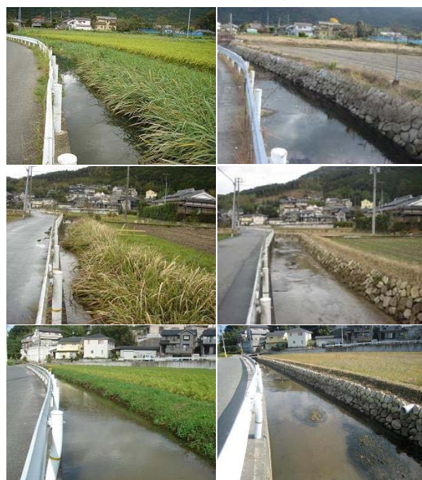
写真 1 護岸改修前と後の様子
