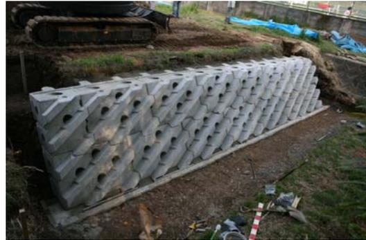
写真5 上段据付完了の斜面
