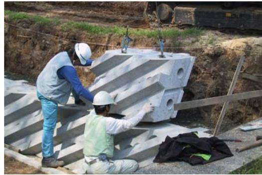
写真3 上段U-1ブロックの据付
