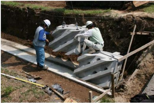
写真2 下段L-2ブロックの据付
