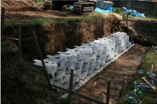
写真4 下段据付完了の斜面
