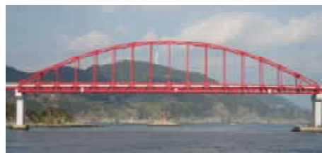
図-1 樺島大橋外観
