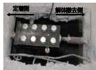
図-2 博多駅プラットホーム改修工事で使用された中間定着具
