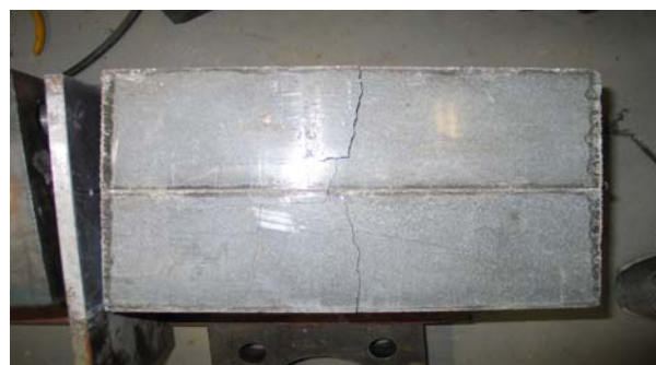
写真 3. ひび割れ状態 (試験体 7)
