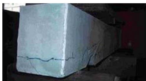
写真-3 主筋の引き込みとひび割れ
