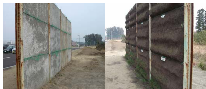
写真-1 ポーラスコンクリートの表面性状
