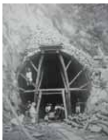
写真-2 トンネル工事 5)
