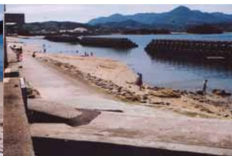
写真6 離岸堤による景観の阻害
