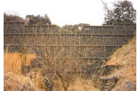
写真-1 鋼製枠砂防堰堤
