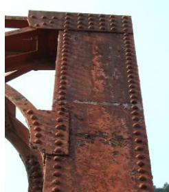
写真1 塗装の劣化
