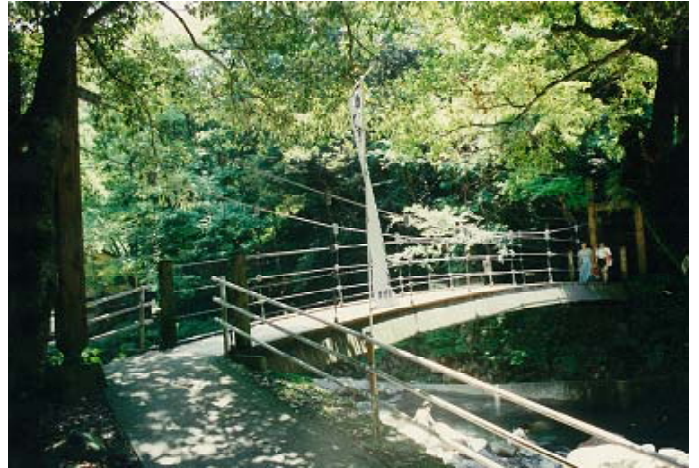
写真－1 桁橋を吊橋に見せかけた例
