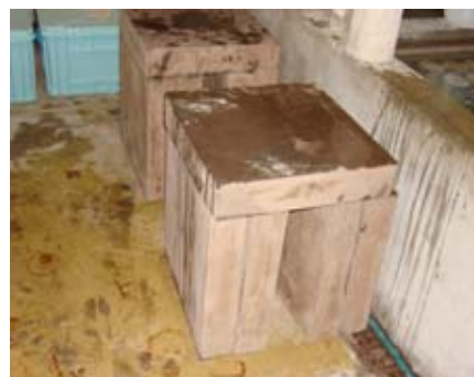
写真-2 平板の養生状況
