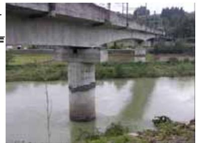
写真 - 1 橋脚損傷図
