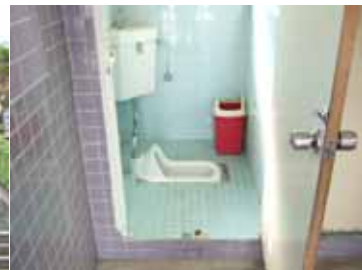
写真-4 利用しにくいトイレ
