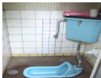
写真-5 公衆トイレ
