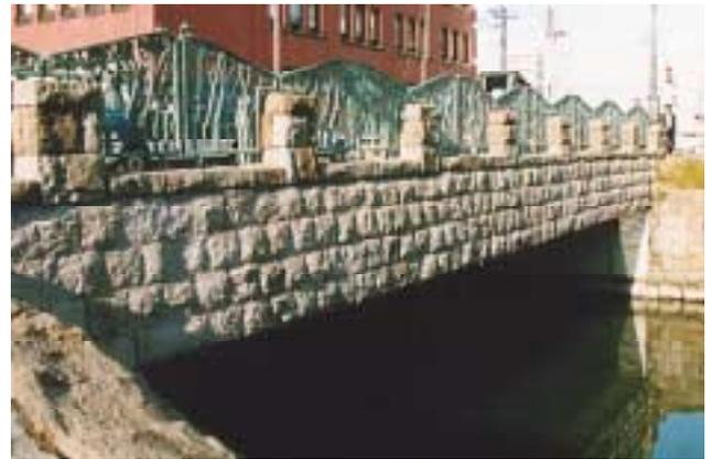
写真-1 桁高変化がない桁に貼った例
