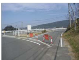
写真-1 未整備の状況
