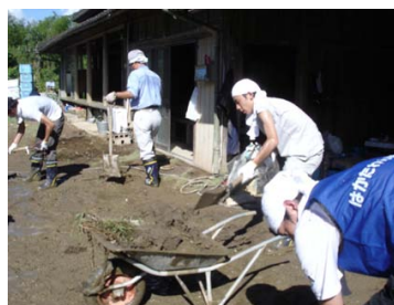
写真 2 泥の撤去作業
