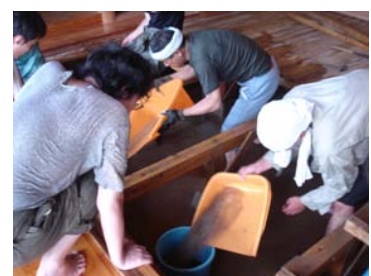
写真 3 床下の水の除去作業
