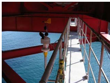
図-7 桁下部設置状況
