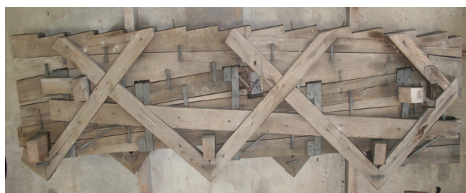
写真-1 錦帯橋のアーチ材ブロック
