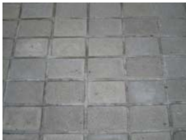
写真 1 敷設インターロッキング
