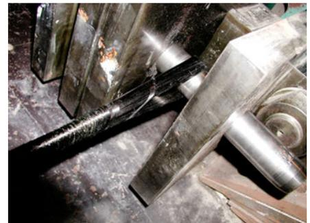
図-3 U型アンカーの緊張治具設置状況
