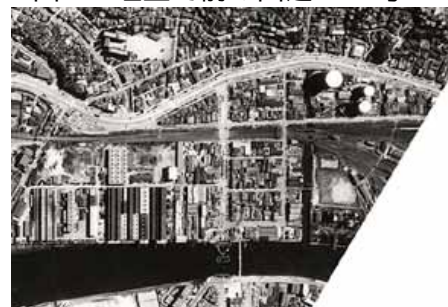
図-6 埋立て後の国道 206 号
