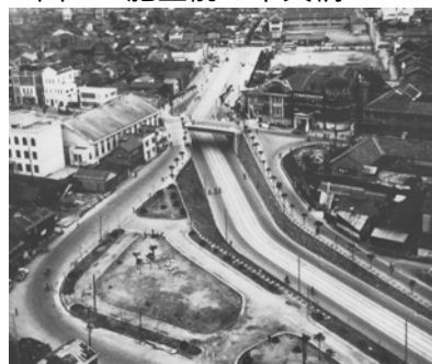
図-8 立体交差「櫻橋」
