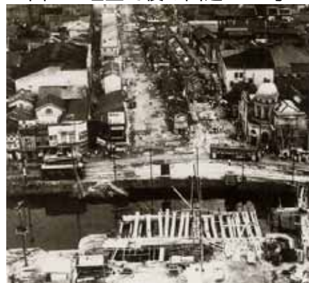
図-7 施工前の中央橋
