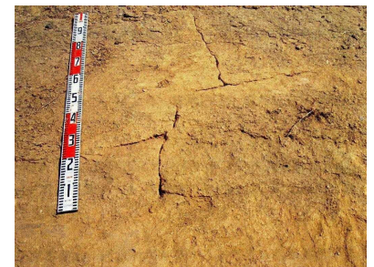
図 1 堤防表面の石灰処理土のクラックの状況
