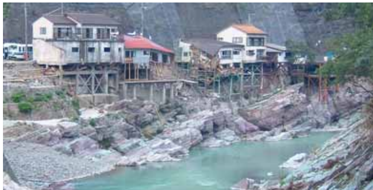
写真-1 出水後の渓谷（国道327号、塚原ダム下流0.8km）
