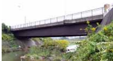
写真-1 調査対象橋梁
