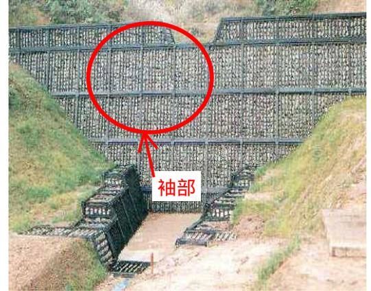
写真-1 鋼製枠砂防えん堤
