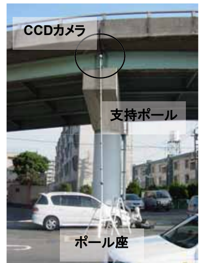
図 1. CCD カメラ設置状況
