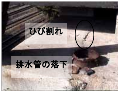
(a) 橋梁横梁上部のひび割れ (b) 支承と沓座の境のモルタルの割れ 図 3. CCD カメラで詳細に視認可能 (排水管)
