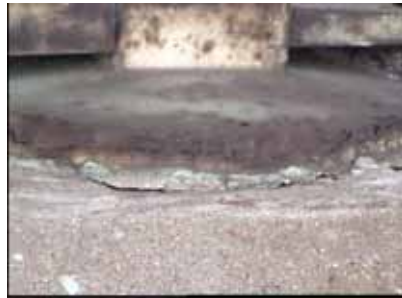
(a) 橋梁横梁上部のひび割れ (b) 支承と沓座の境のモルタルの割れ 図 3. CCD カメラで詳細に視認可能 (排水管)
