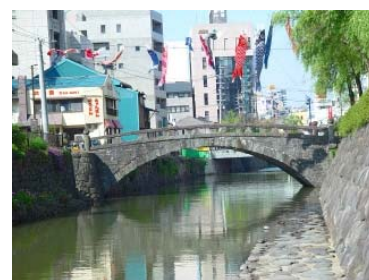
写真 - 1 袋橋全景
