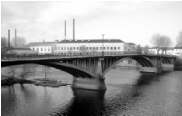
写真 - 1 シャテルロー橋
