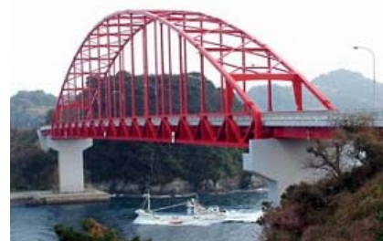
図-2 樺島大橋の外観
