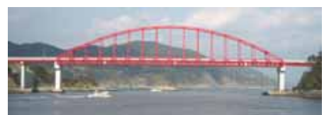
写真-1 樺島大橋全景
