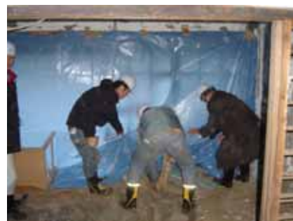
写真-2 調査対象室内状況
