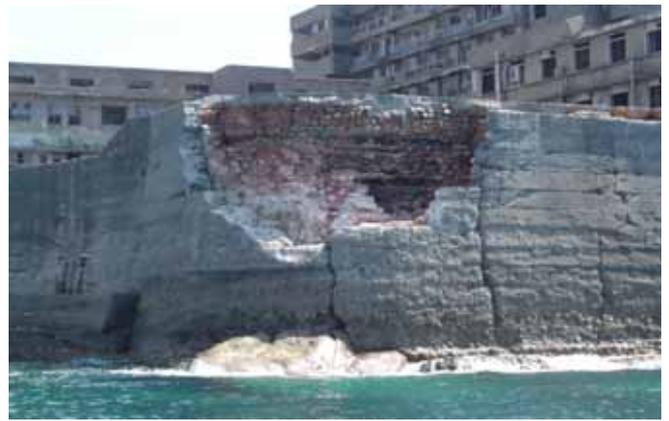
写真 - 2 護岸の破損部分
