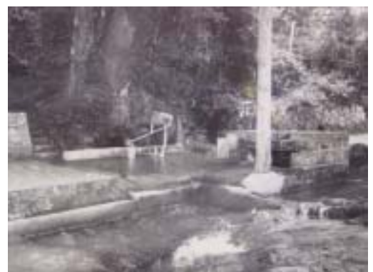
写真-3 改修前の天の眞名井
