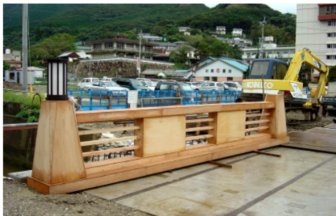
図-7 江尻橋のモックアップ
