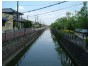
図-2 コンクリート護岸で整備されたクリーク
