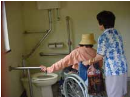
写真 - 4 障害者用トイレ
