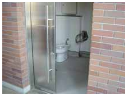
写真 - 5 障害者用トイレ
