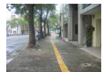
写真 - 6 波打ち歩道
